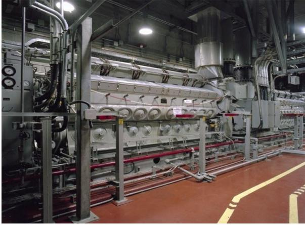
**Figura 37. Generador diésel de emergencia**
