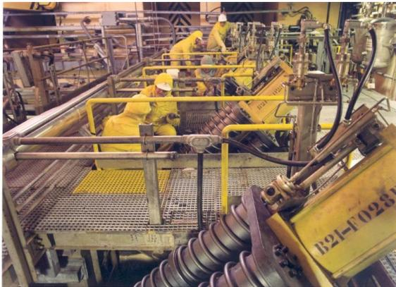
**Figura 38. Válvulas de aislamiento de las líneas de vapor principal en el edificio de contención para una central BWR**
