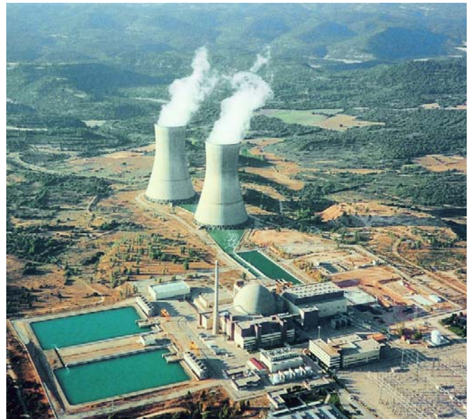
La producción de energía eléctrica es la principal aplicación del uranio. Central Nuclear de Trillo en Guadalajara.
