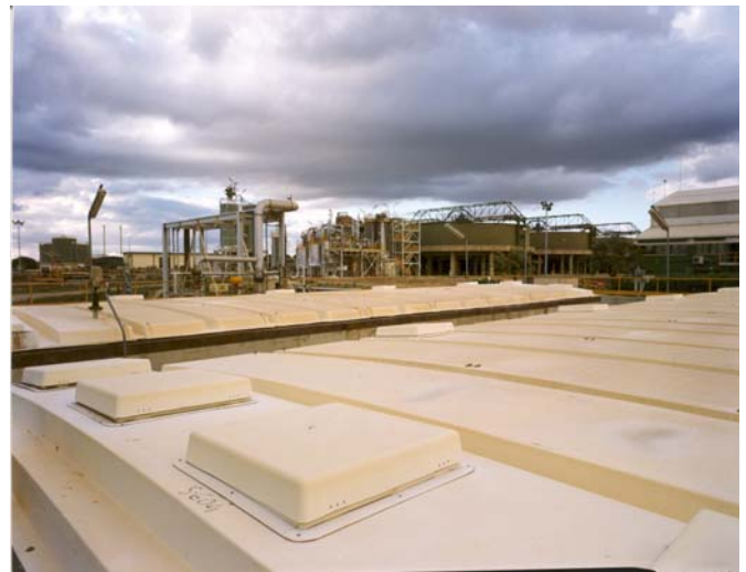
Baterías de los sedimentadores de extracción con disolventes orgánicos en primer plano.
